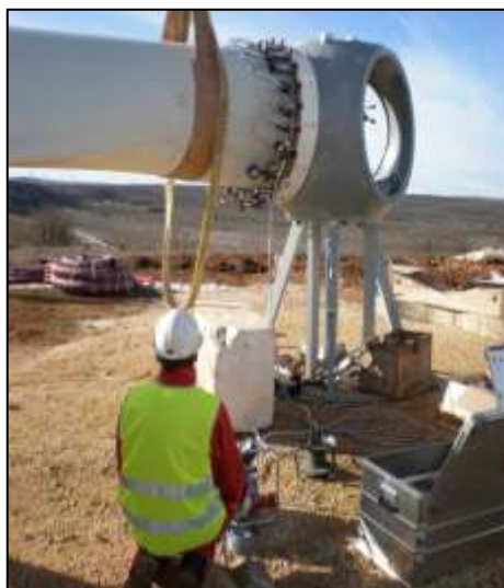
Składanie ostrzy rotacyjnych turbiny wiatrowej z wielorakimi typami cylindrów MS 24 - 10.9 na turbinie 850kW (wielo-naprężeniowe).
