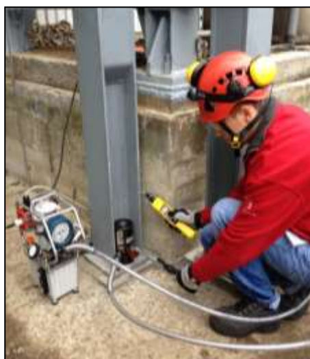
Podstawa połączeń śrubowych z typem ES 30, M30, z typem cylindra napinającego śrubę i pompą serwisową
