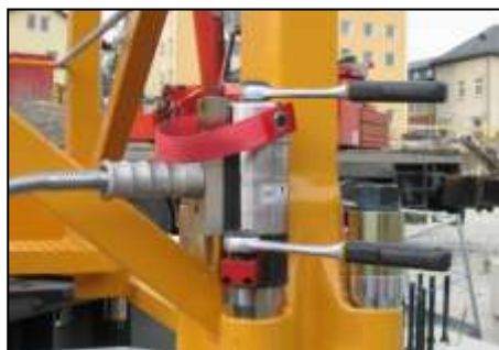
Montaż odcinków wieży za pomocą dźwigu z typem napinacza MS 45 - 12.9.
